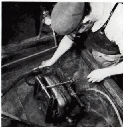
Arrêtons-nous un instant à la fabrication du réservoir ; pour que son étanchéité soit parfaite, les deux coquilles qui le composent sont soudées électriquement à la molette.
